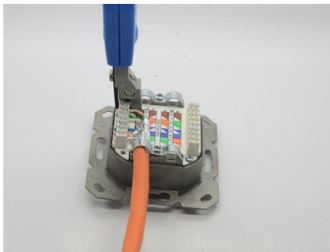
Aufschalten der Aderpaare mit LSA-Werkzeug Terminate the wires with LSA impact tool
